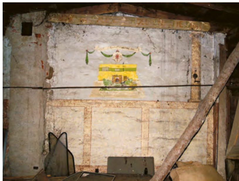
Ryc. 2 Nowy Staw, budynek gospodarczy, malowidło oraz belka z napisem przed konserwacją i transferem, 2020 r., fot. J. Wiśniewski
